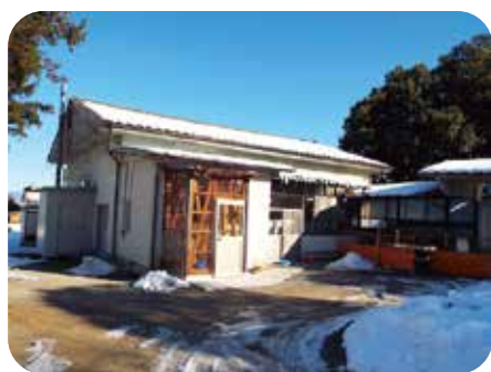
現在の東塩田小学校の給食調理場は、昭和37年に音楽室として建てられた。
